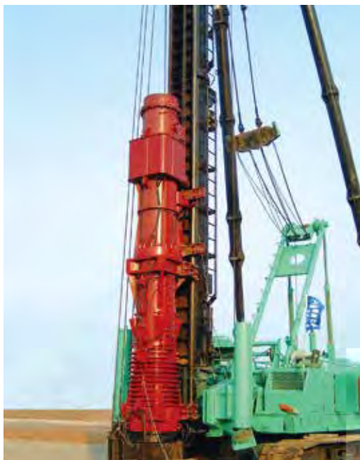
挂筒式柴油锤施工
