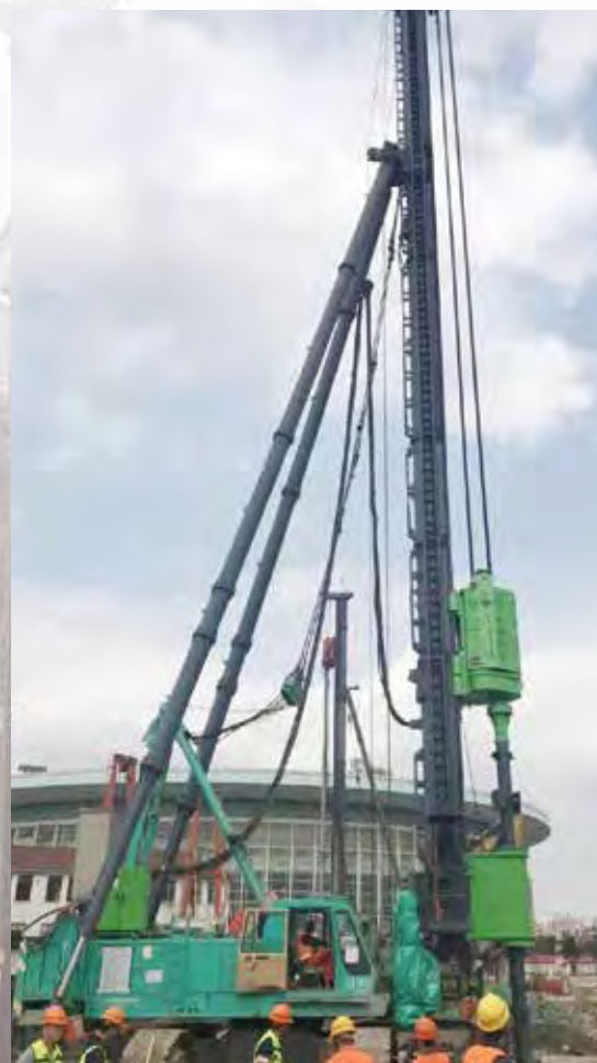
挂静钻根植工法钻机施工
