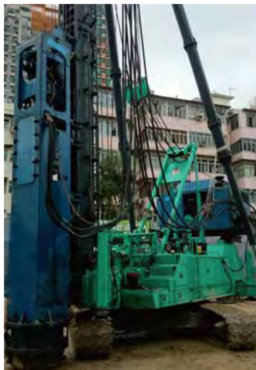
挂液压锤施工
