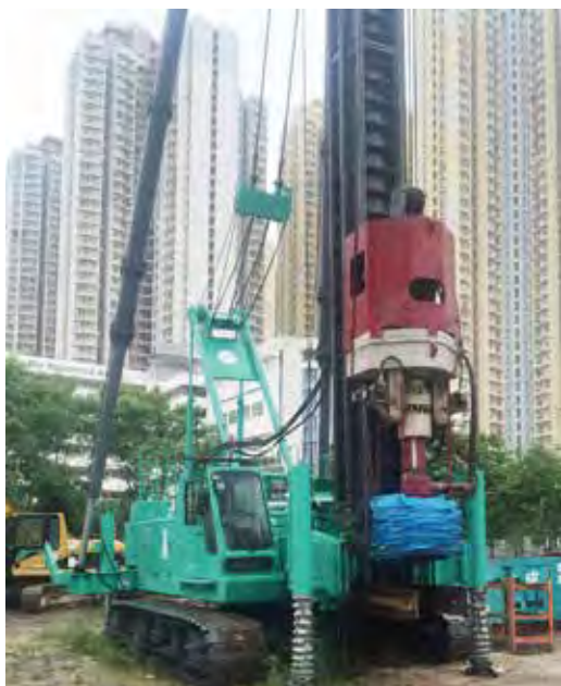
挂入岩钻机施工
