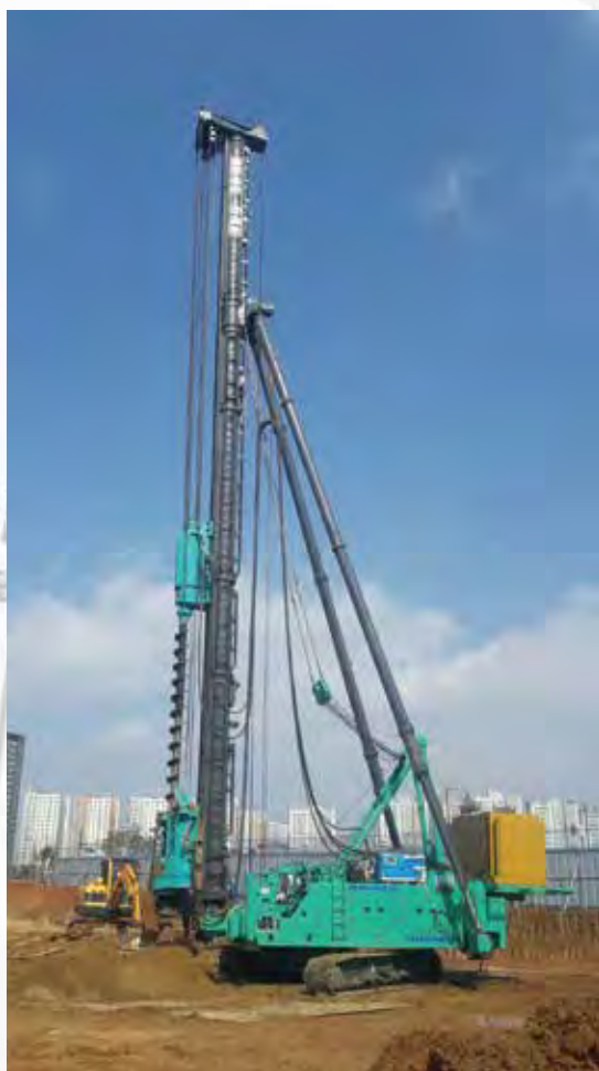
挂双动力头钻机施工
