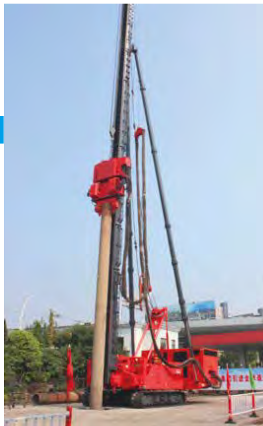
挂液压振动锤施工
